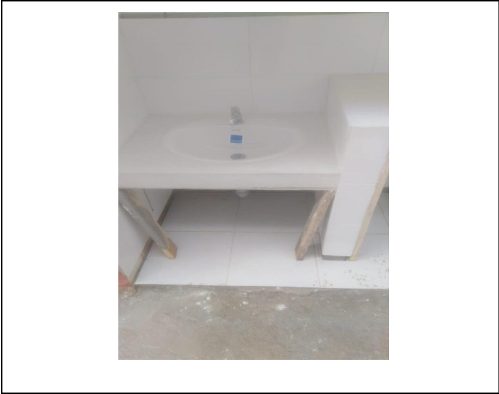
1. I.E. San Andres Sede Principal (Dolores Tolima) Avance de obra:
