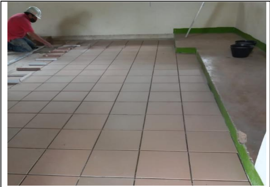
1. I.E.San Andres - Sede Principal ( Dolores - Tolima) AVANCE DE OBRA :
