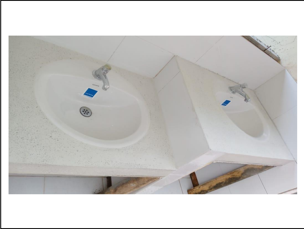
1. I.E.San Andres - Sede Principal (Dolores - Tolima) AVANCE DE OBRA:
